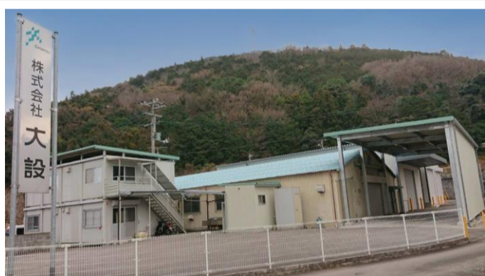
株式会社大設 徳島工場 スパイラルダクトを製造する拠点、1991年開設。 2018年拡大移転 徳島県三好郡東みよし町西庄字岩神11-1
